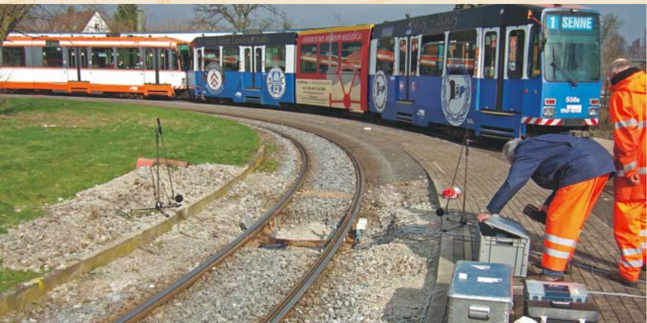
Ausführung einer Kurvenkreischmessung des Fachgebiets Schienenfahrzeuge und Technische Akustik der TU Berlin bei den Stadtwerken Bielefeld am 07. April 2006 in der Wendeschleife Milse. Im Hintergrund zwei Triebwagen vom Typ M8C. Quellen/ Fotos: Autor
